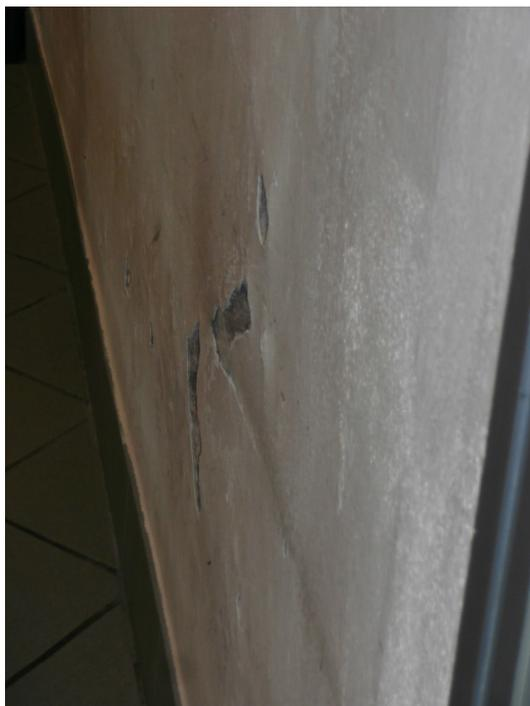
Sul blocco dei servizi igienici sono previsti intervento di risanamento totale per l'eliminazione di tracce di umidità dovute a perdite di acqua dalle condotte, oltre alla sostituzione di apparecchi sanitari non idonei per il tipo di struttura
