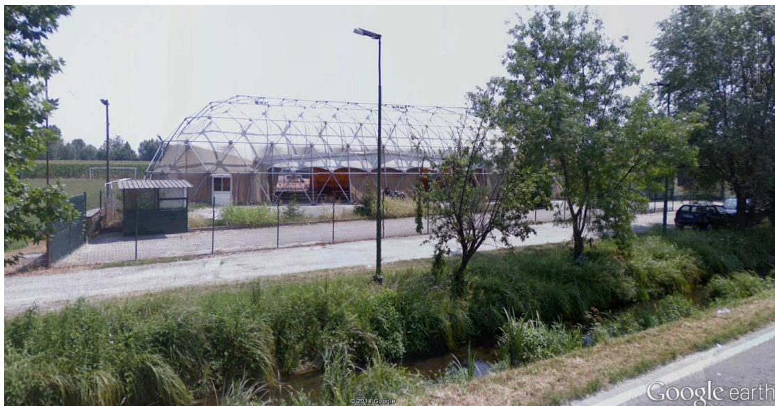
Vista dello stato attuale: il bocciodromo
